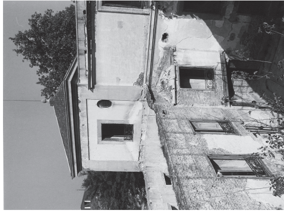
Fig. 42: Restos del arranque de las bóvedas del ala norte
