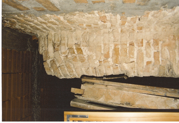
Fig. 42: Restos del arranque de las bóvedas del ala norte
